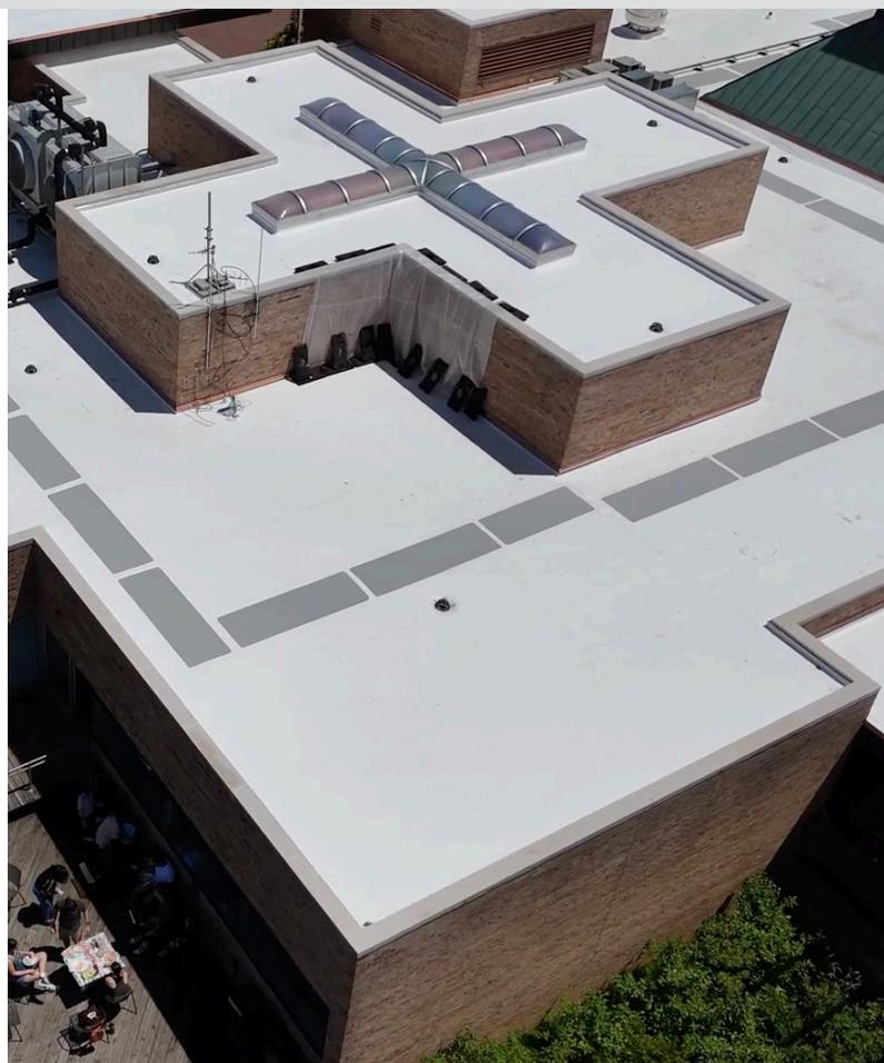
Después de colocar el aislamiento, el equipo de A-1 aplicó completamente otra capa de placa DensDeck de media pulgada sobre la parte superior. Luego, aplicaron con rodillo la membrana Sure-Flex PVC de 10 pies de ancho y 80 milésimas de pulgada con el pegamento de base acuosa Sure-Flex PVC HydroBond, un adhesivo de dispersión de un lado que se aplica en húmedo y garantiza una fijación de alta resistencia y duradera.
