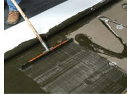
Pegamento de poliéster de asfalto modificado de aplicación de un lado en húmedo diseñado para adherir a membranas VersiFleece AC y a láminas base modificadas de Versico.
