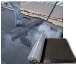
Una hoja de base de asfalto modificado con SBS de 90 milésimas de pulgada. Puede utilizarse en sistemas de cubiertas multicapa como barrera de aire y vapor, o como cubierta temporal durante un máximo de 60 días. Este producto está reforzado con fibra de vidrio y cumple o supera los requisitos de ASTM 6363 Tipo 1. Cuando se utiliza como barrera de aire y vapor, los sustratos adecuados incluyen hormigón (requiere imprimación), DensDeck Prime y SECUROCK.
