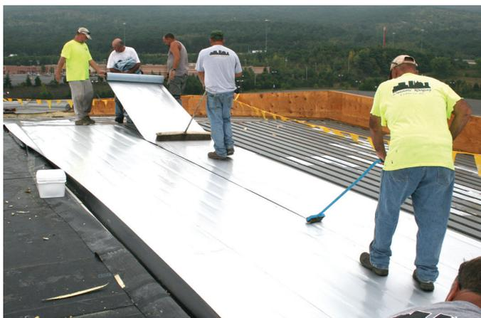
8. Sur les platelages profilés, les extrémités de l'ensemble pare-air ou pare-vapeur doivent être recouvertes d'une bande supplémentaire de VapAir Seal MD ou d'une plaque métallique plate d'environ 15 cm (6 po) de large pour un meilleur support.
