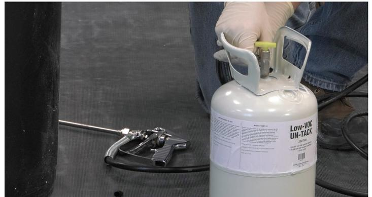
Cuando retire la punta de aspersión de la pistola para limpiarla o reemplazarla, no es necesario aliviar la presión en el conjunto de la pistola y la manguera. Asegúrese de que el tope de seguridad del gatillo esté posicionado de manera que no permita que la pistola funcione. Use gafas de seguridad durante este procedimiento y siempre que rocíe el adhesivo.
